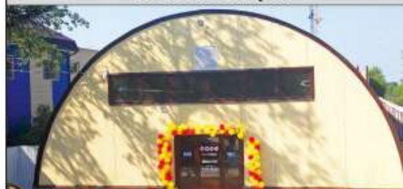
СКЛАДСКИЕ И ПРОИЗВОДСТВЕННЫЕ ПОМЕЩЕНИЯ
